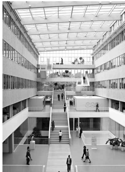
Hoofdkantoor TNT Hoofddorp (Paul de Ruiter, 2011)
